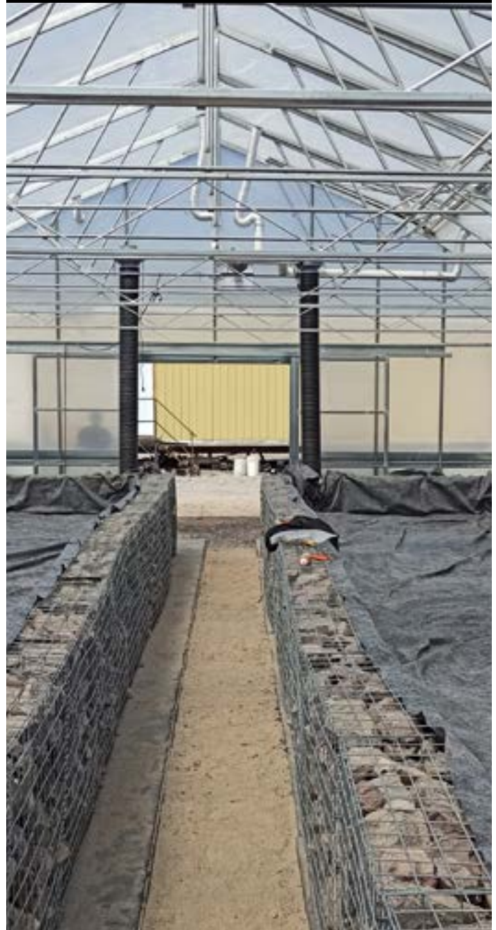
Construction of stone beds (photo : Timothée Maheux, 2022)
